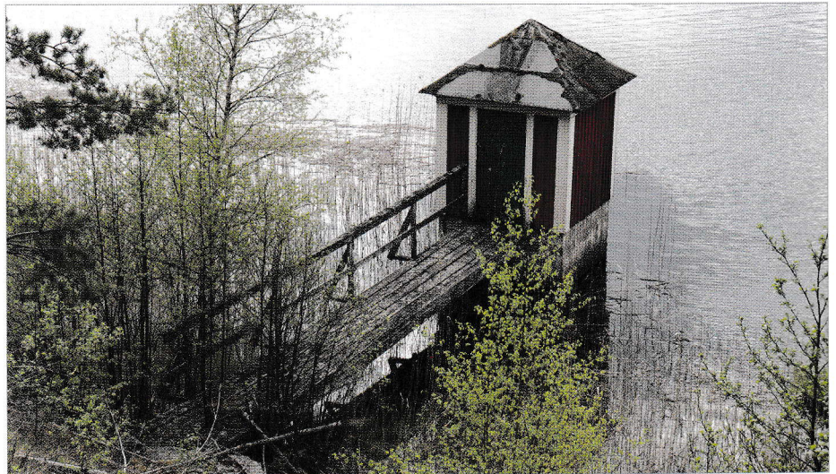
Pumphus i sjön Mellan-Svan. Järnvägen ÅmÅJ, Åmål - Årjängs Järnväg gick där nu länsväg 524 går; vattentornet ligger på andra sidan vägen.
