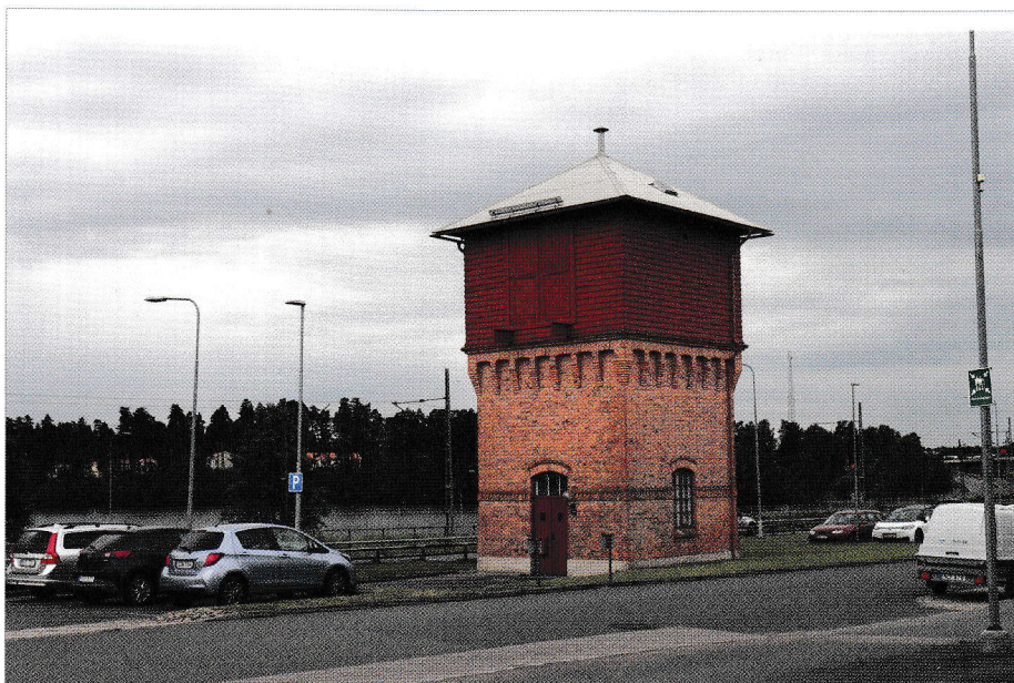
Mullsjö, vattentornet, foto: 2024. Exteriör.
